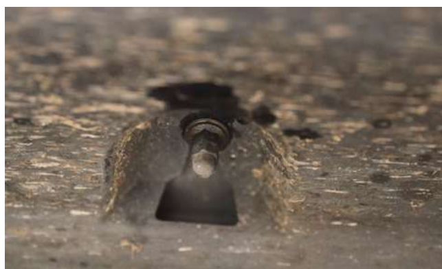
Bild 2: Hutmuttern entfernen
